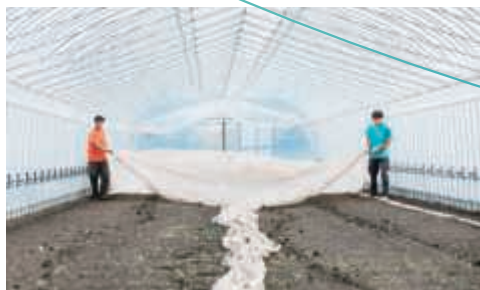
微生物が活発に働けるよう地温を上げるための、ビニール張りのようす。作業を行っているのは若手スタッフたち。
