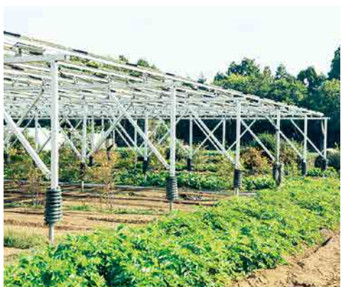
発電と農業を兼ねる「ソーラーシェアリング」
