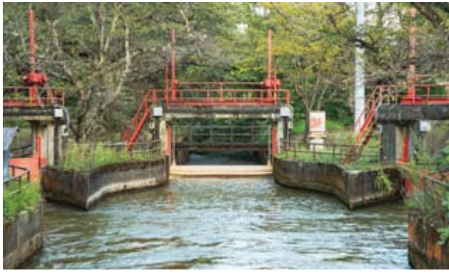
発電所のすぐ下流にある「分水工」。水門を調整し、ダムから流れてくる水を各地域の用水路と川に分けます。
