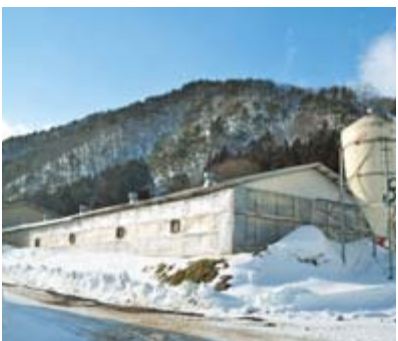
米沢郷牧場の鶏舎のひとつ。ぐると覆うビニールは寒対策の一環です。鶏舎内を暖かく保つための燃料価格も上がっています。
