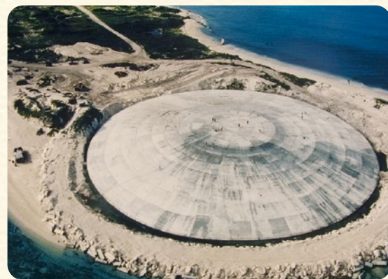
米国の原水爆実験で生じた「核のゴミ」を格納するコンクリートドーム。マーシャル諸島の工二ウエトク環礁にあり老朽化による放射能漏れが懸念されている(写真/米国立公文書館)
