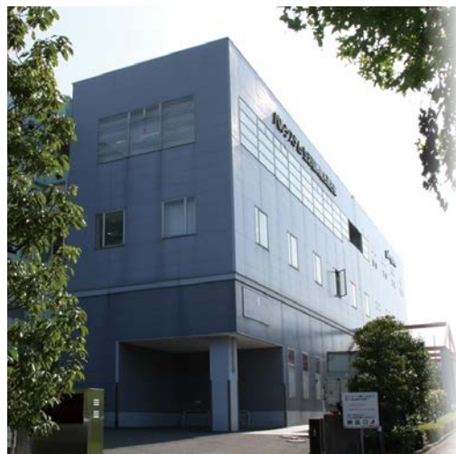
パルシステム商品検査センター
